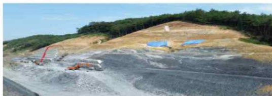
그림 2.16 2016. 12 절토사면 공사 현황
